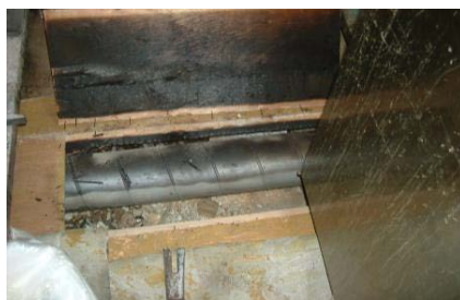
剥き出しの排気管
