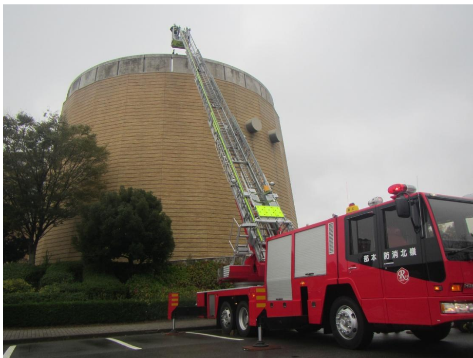
梯子車による屋上からの救出訓練
